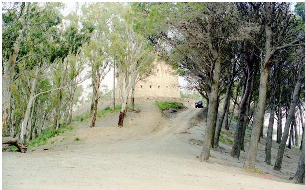
Figura 7. El fortín de Aranguren se ubica justamente en la cresta de la loma Entre Fuertes. Debido al proceso de reptación de las capas superiores del suelo, una o ambas mitades del fuerte se desliza en direcciones opuestas por la superficie curva de la cresta de la loma, ello puede explicar la divergencia angular que se observa entre los lados de la fractura.
